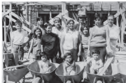
Cuadrillas de apoyo a la construcción Villa Ministro Carlos Cortés. Fundación Villa San Luis.
