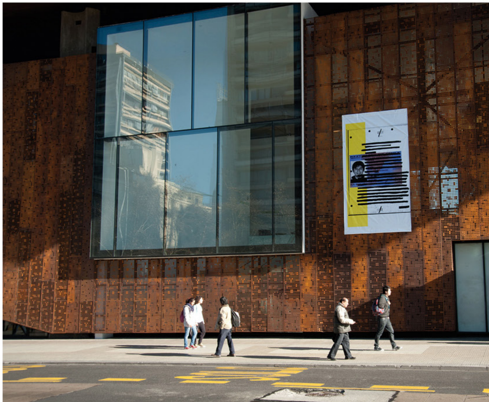
En una de las paredes exteriores que da hacia la Alameda del Centro Cultural Gabriela Mistral (GAM) estuvo instalada la obra de Voluspa Jarpa.
